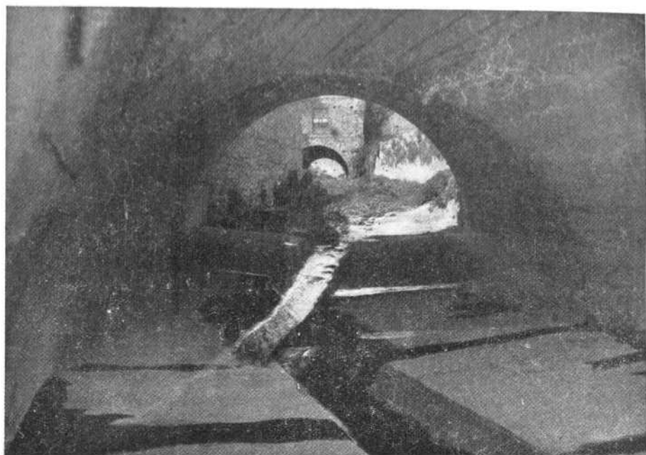
Cubrimiento y canalización del río Keiles
